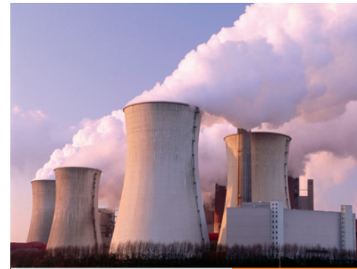
Central elèctrica. Fig. 10.11
