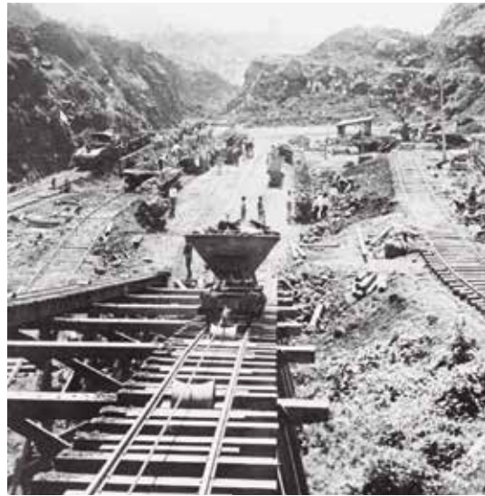
Trabajos macizo de la culebra, 1907
