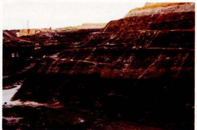
Fig. 22.3 Mineração a céu-aberto de carvão na região de Charqueadas (RS), onde pode-se observar a grande mobilização de material para exploração do carvão mineral. Foto: S. L. F. de Matos.
