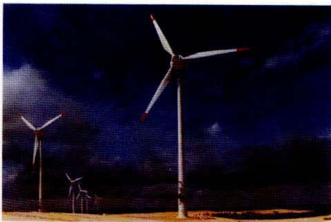
Fig. 22.18 Usina eólica da Taíba, CE, que produz 5 MW, é a primeira a ser implantada sobre dunas. Foto: Wobben Windpower.
